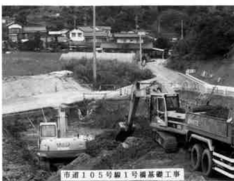
市道105号線1号橋基礎工事
