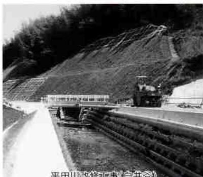
平田川改修工事(白井谷)
